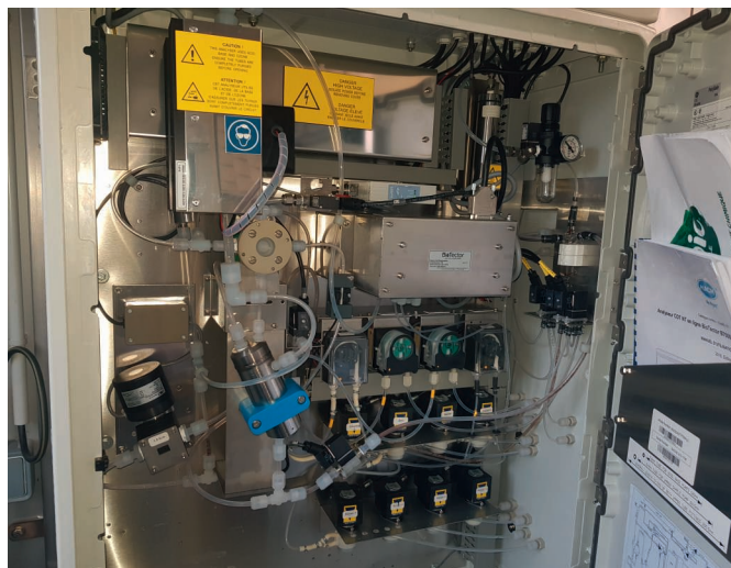
Biotector B7000-analyser voor TOC/TN met zes flows
