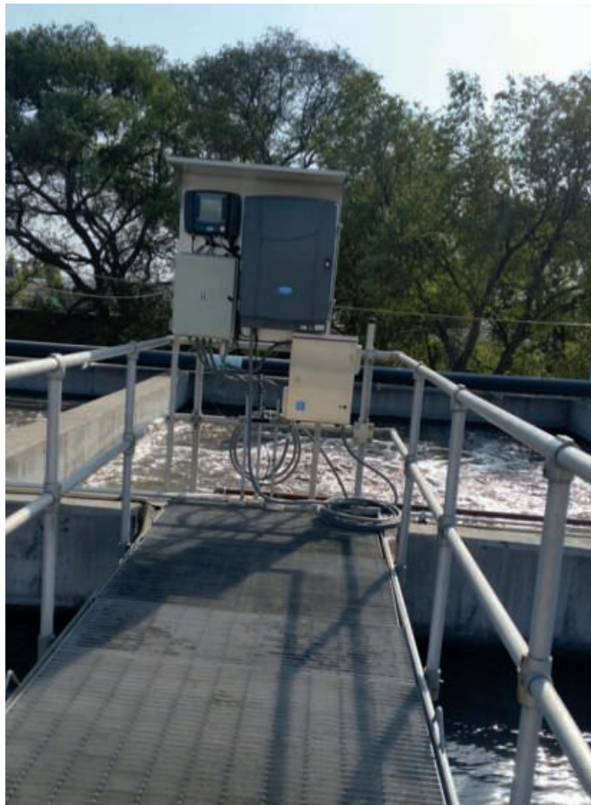
Afbeelding 7. P-RTC geïnstalleerd en in bedrijf
