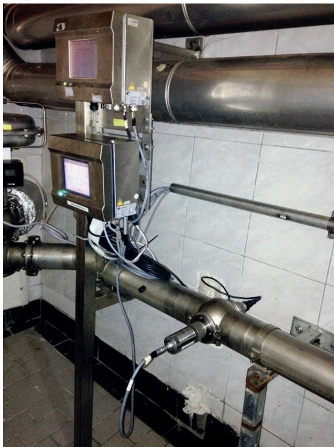
Afb. 2. Hach 410-transmitters – standaardinstallatie
